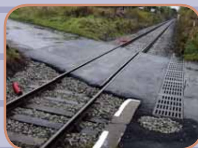
Rekonstrukce koleje v úseku Bakov - Česká Lípa
