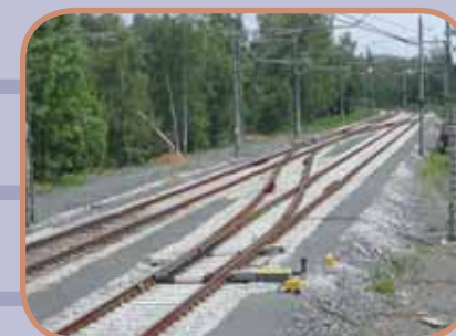
Rekonstrukce kolejové spojky v žst. Karlovy Vary
