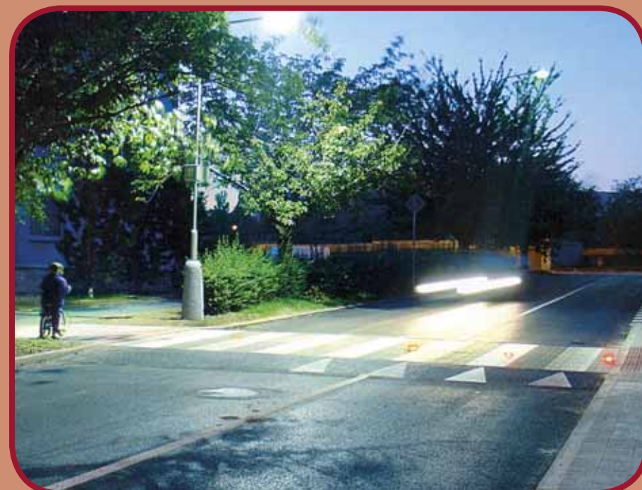
Technologie zapuštěných LED svítidel na přechodu v Litoměřicích, první realizace v ČR
